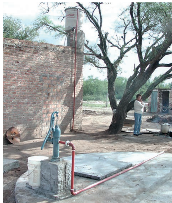
Figura 11. Mecanismo de bombeo manual para extraer y elevar agua con una bomba de hierro fundido
